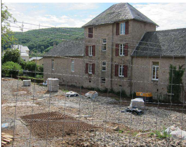
L'arrière du bâtiment où sera construit l'extension en ossature bois
