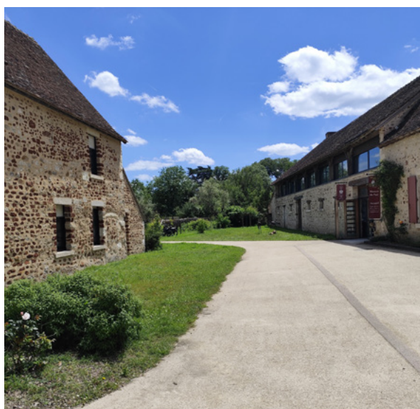
Habiter Parc – Parc de la Brenne
